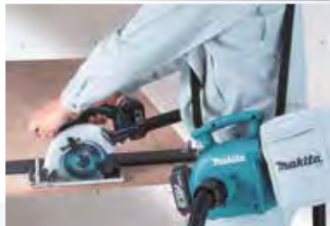
Corte de madera (con sierra circular)
