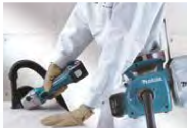
Corte de concreto (con esmeriladora)
