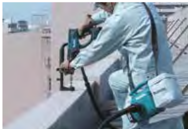
Perforación de concreto (con martillo combinado)
